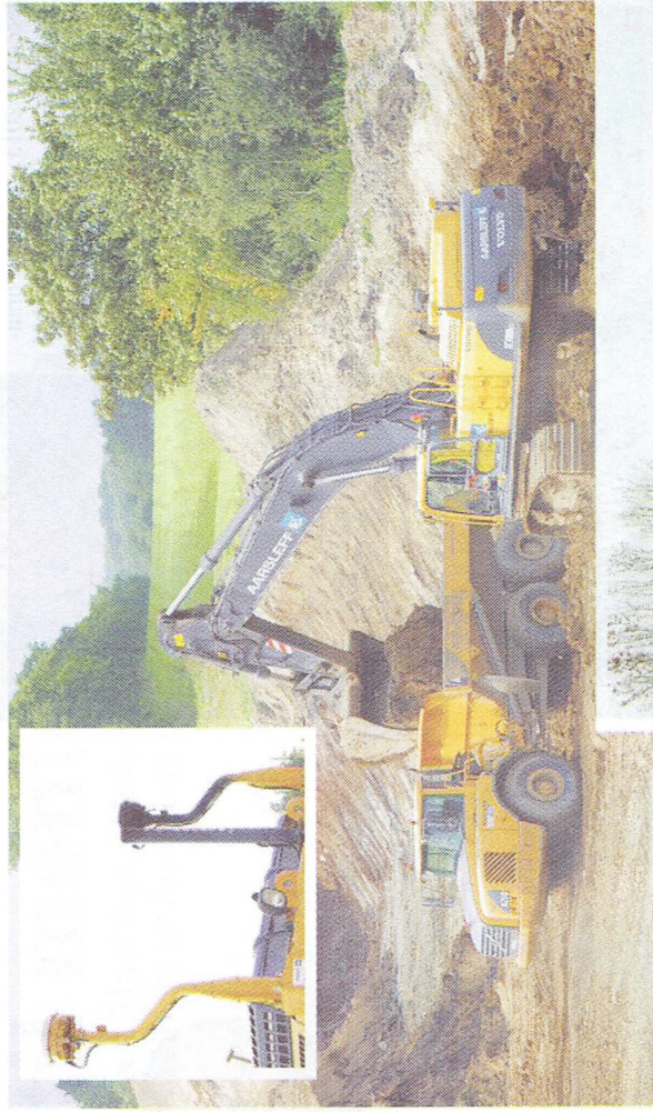
Sønderborg-motorvejen blev anlagt udelukkende ved brug af GPS-baseret 3D maskinstyring og uden brug af afsævningspele.
